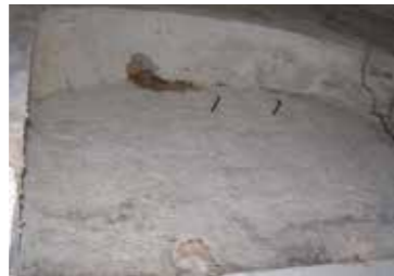
Embocadura del edículo del “Santo Cristo”, antigua Capilla de Ánimas (Murcia, Iglesia de Santa Catalina de Alejandría)
